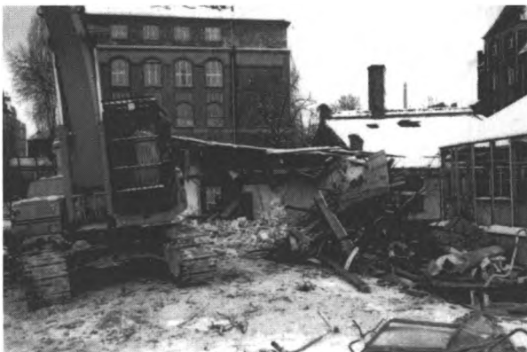
Abb. 8: Klammheimlicher Abriss der Krebsbaracke der Charite 1996
